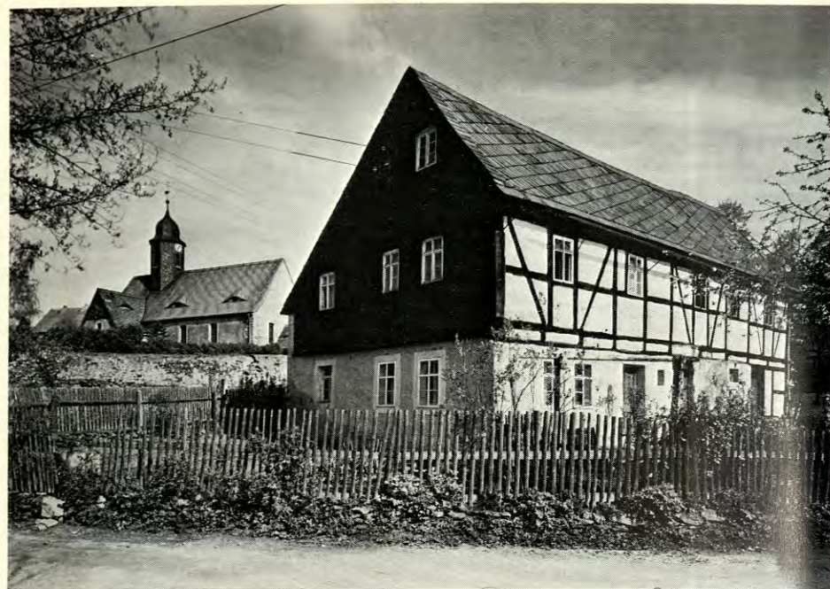
10. Hammerarbeiterhaus in Obergruna. Anbau nach hinten, Giebel verbrettert, links Wohnstube, Tür, Fensterluke, dann Stalltür, Stallfenster, Speichertür. Hintergrund Dorfkirche. Foto 173017 Deutsche Fotothek Dresden.
