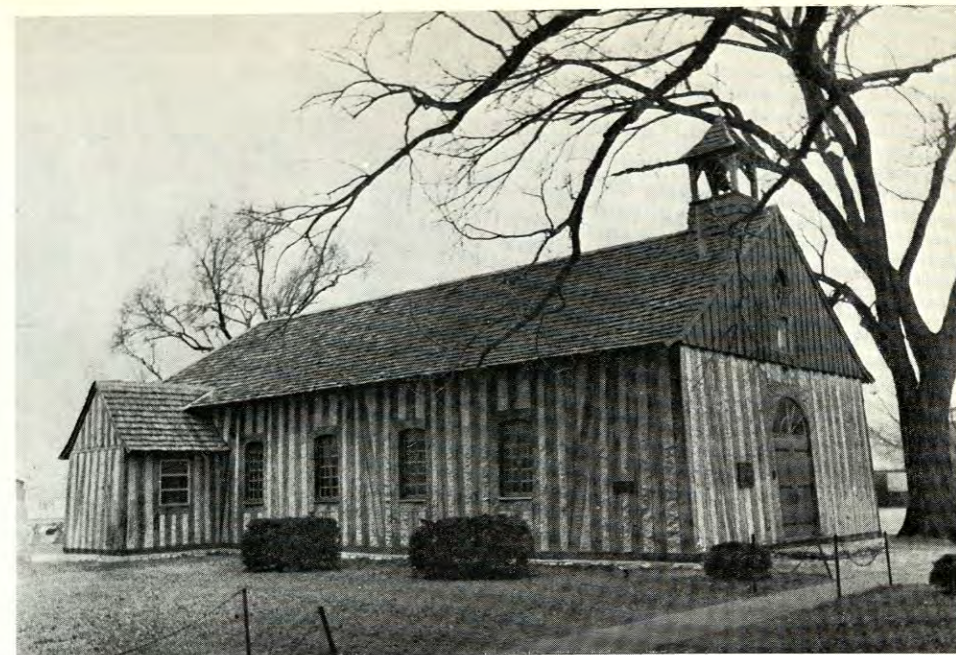
1. Eglise de la Sainte Famille, construite en 1799. Cahokia, Illinois.
